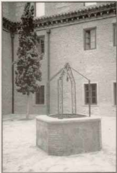
El pozo del monasterio de Vico que recogía sus aguas del Hontanar y fuente de San Marcos.
