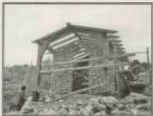
Nuevo templo de San Marcos en construcción.
